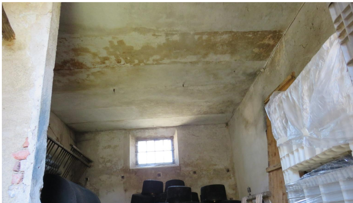
Solaio B – vista verso nord
