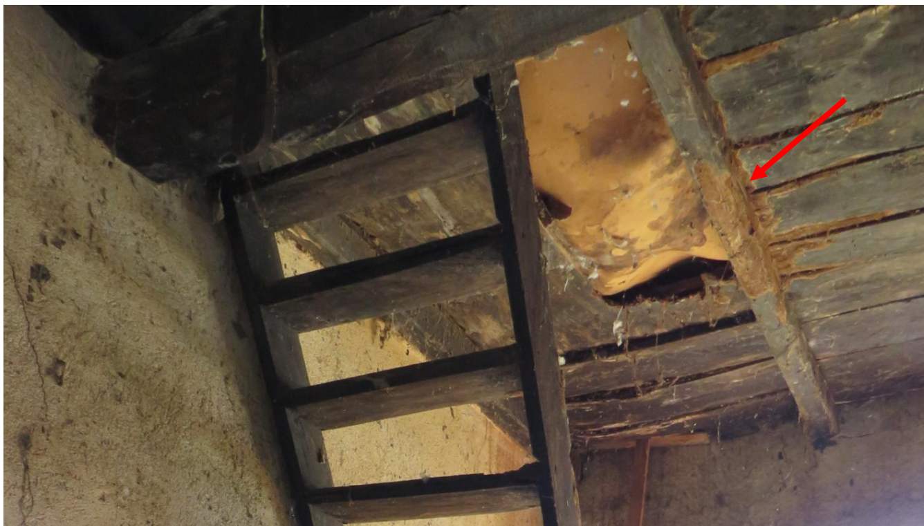
Solaio A – vista verso sud
