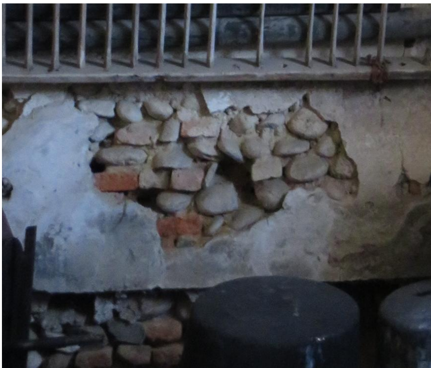
Muratura portante lato ovest
