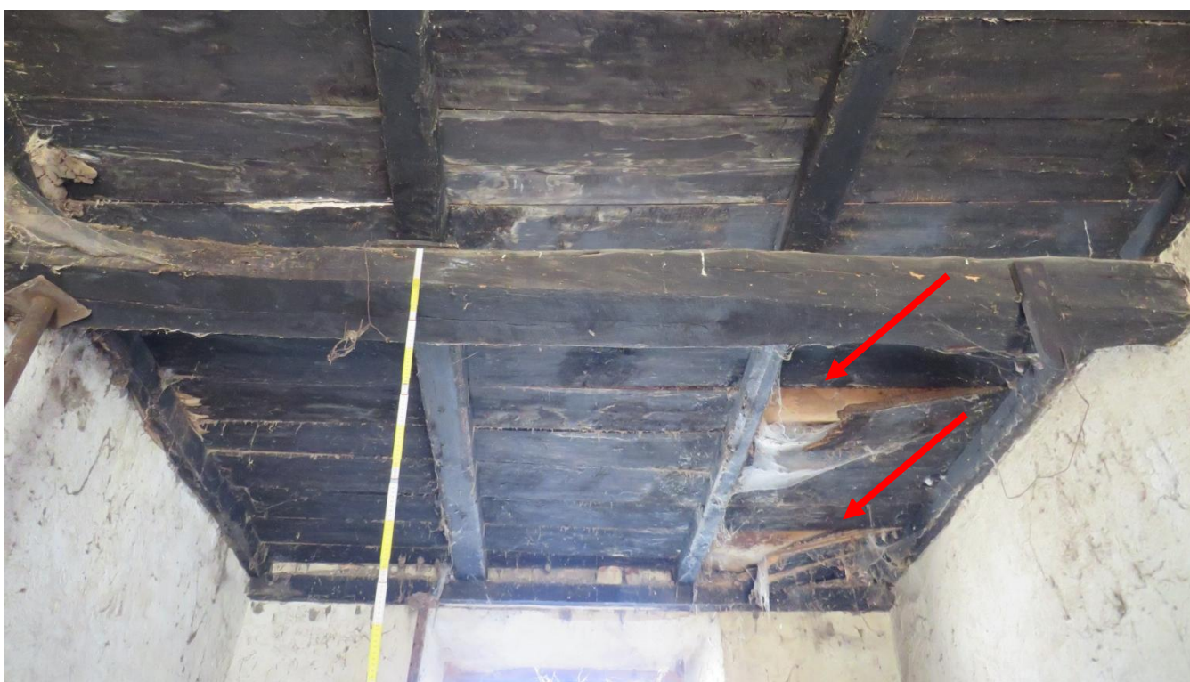
Solaio A – vista verso nord
