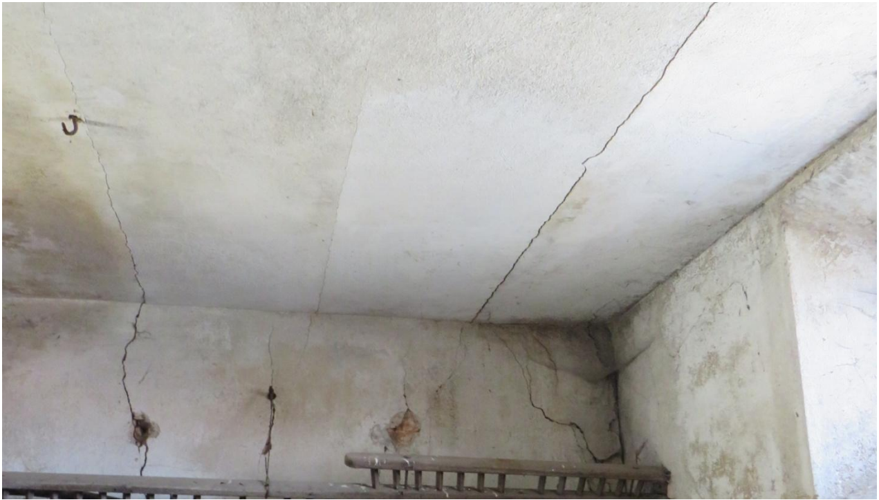
Solaio B – particolare vista verso nord-ovest
