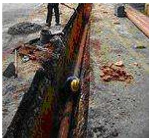
Trattasi della movimentazione e posa in opera di tubi flessibili (PE, PVC ed analoghi) e relative opere prefabbricate (camerette di ispezione, pozzetti e simili). In particolare si prevede:
