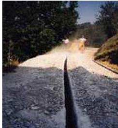
Trattasi dell'esecuzione di rimozione dell'asfalto mediante l'utilizzo di macchina taglia asfalto a disco, dotata di regolazione della profondità di taglio per mezzo dell'abbassamento del disco, ed allontanamento dei materiali di risulta.
