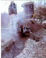
Per scavi a sezione ristretta (o in trincea) si intendono quelli continui (correnti) di sezione trasversale ristretta che vengono utilizzati per la posa di tubazioni, sottoservizi, ecc...
