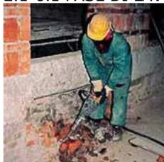
Trattasi delle operazioni di demolizione di strutture collegate ai corpi di fabbrica da non demolire eseguita con mezzi meccanici o a mano dove occorra.
