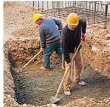
Trattasi della esecuzione di piccoli scavi a sezione obbligata eseguiti manualmente mediante l'utilizzo di pala e piccone.
