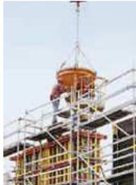
Per la realizzazione di strutture in c.a., si può anche usare calcestruzzo prodotto in cantiere, mediante l'ausilio di benna a secchione (per i cantieri di piccole dimensioni sprovvisti di un sistema di pompaggio) oppure mediante l'utilizzo di pompa per CLS. In generale, l'esecuzione del getto di conglomerato cementizio avviene secondo le seguenti modalità:
